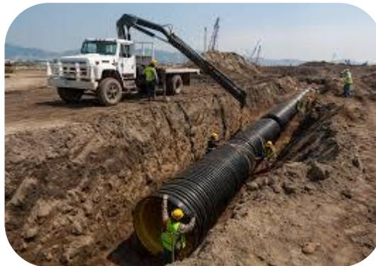
**Figura 9: Instalación de drenaje en áreas específicas**
