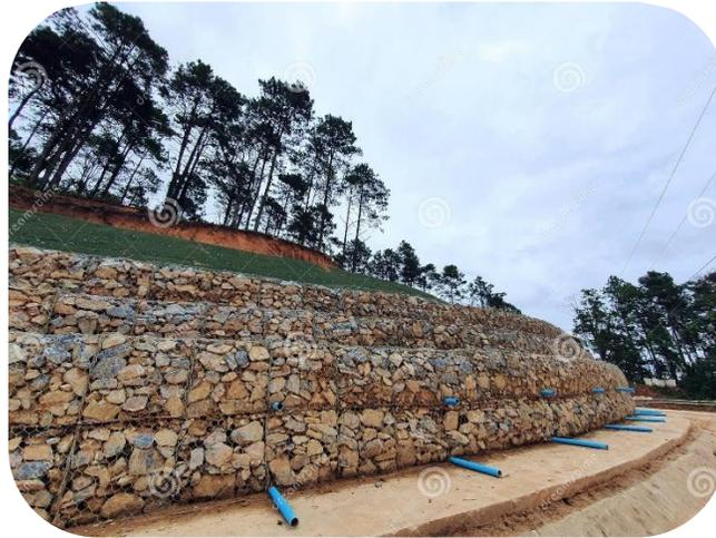
**Figura 14: Muro de contención con tubos de escurrimiento de agua**
